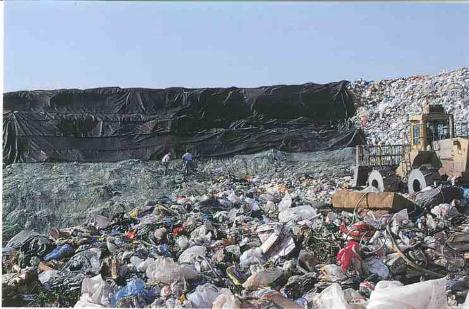
Stesura del telo adsorbeco su scarpata
