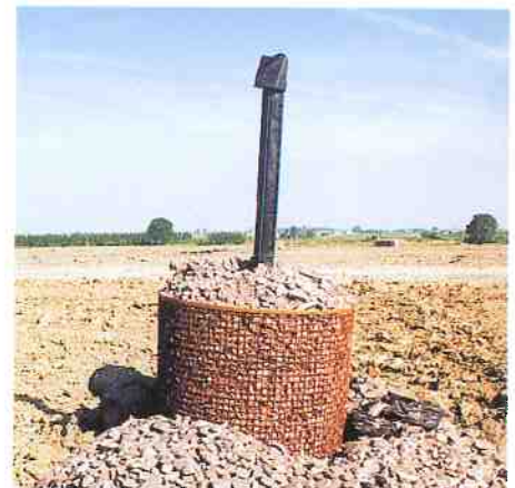
Torrino di scarico biogas convenzionale
