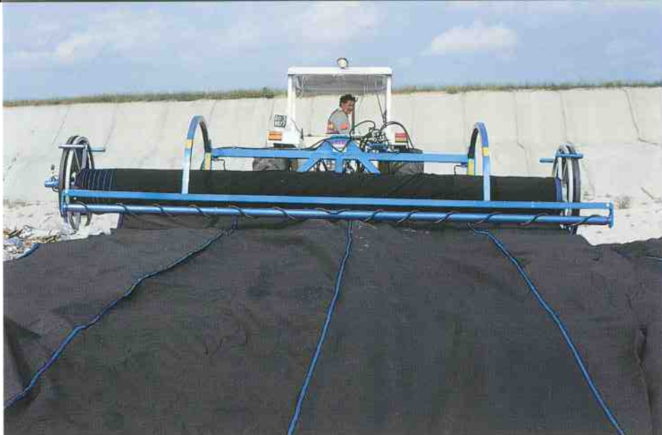
Stesura del telo adsorbeco su piano orizzontale
