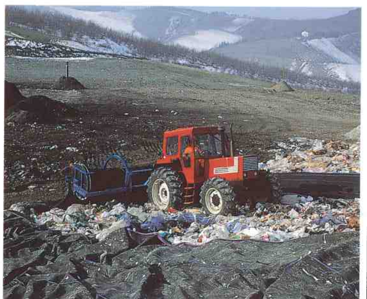
Stesura di adsorbeco su piano inclinato
